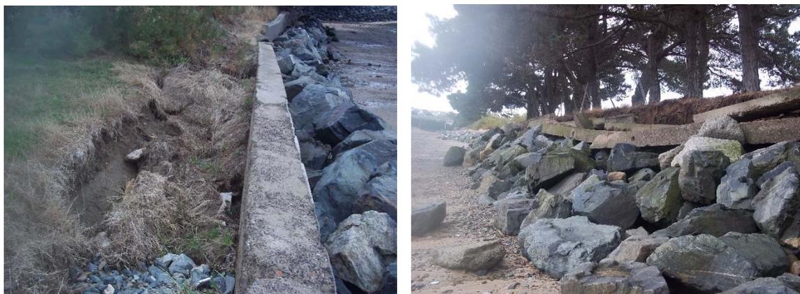
La digue de Kerdreiz était initialement constituée par un mur en béton banché d'une épaisseur de 35 à 50 cm sur une hauteur d'1.2m à 1.5m.
